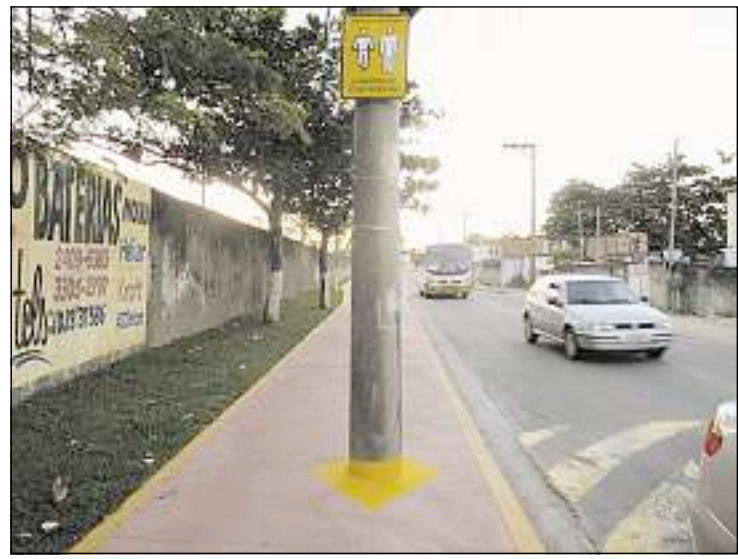
POSTE NO meio da ciclovia: pintura na base para alertar os ciclistas
